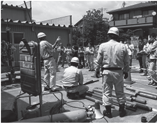
ボーリング作業見学会（地盤工学会との共催行事）
