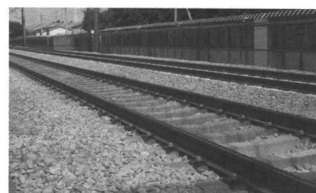
図3 バラスト軌道の概略
