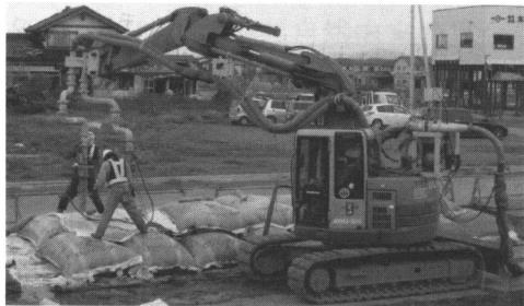
写真6 圧送されたヘドロの充填
