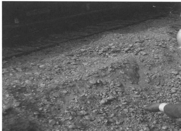
写真1 クリンカアッシュの下層路盤への適用例
