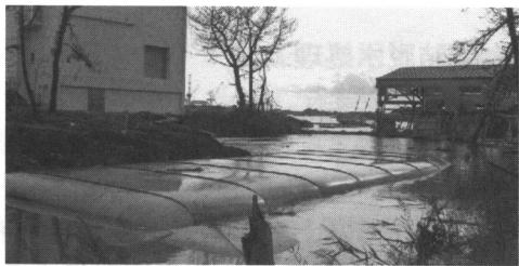
写真7 定置型袋を用いた盛土
