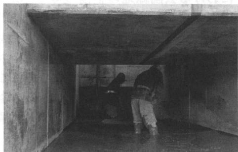
写真4 気泡混合土の打設状況
