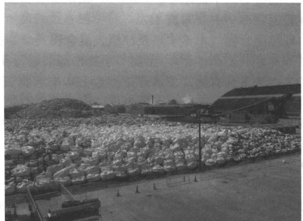
写真9 フレコンバック詰めした混合廃棄物
