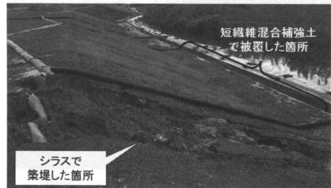
写真5 シラスの短纖維混合補強土（施工後3ヶ月）
