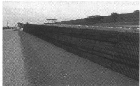
写真 1 ジオグリッドによるのり面補強
