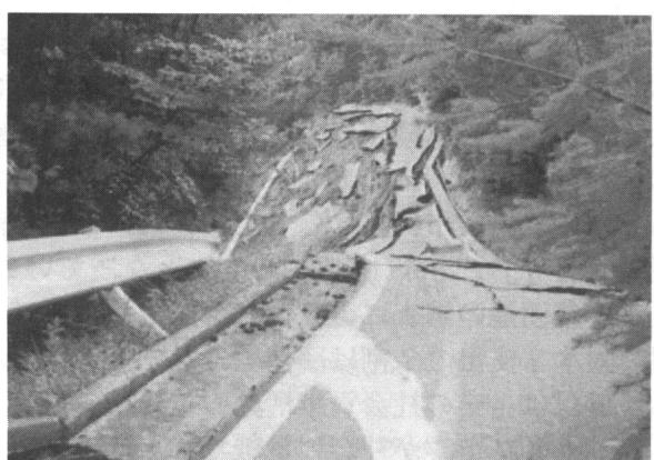
写真 2 地すべり頭部有料道路の崩落状況
