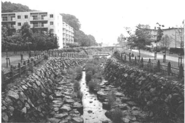
図4 石張り護岸の多自然型河川改修
