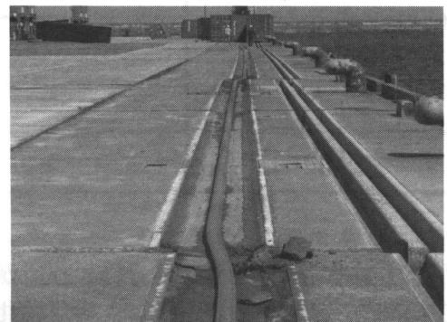
写真5 北埠頭重力式岸壁（-12 m）レールの湾曲
