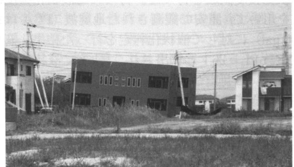
写真1 液状化により大きく傾斜した建物
