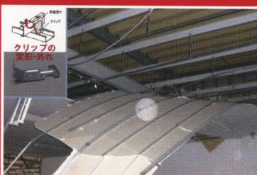
金具のはずれによる天井の脱落
