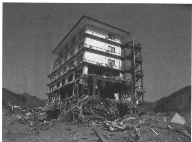
写真5 鉄骨造建物の津波被害の例
