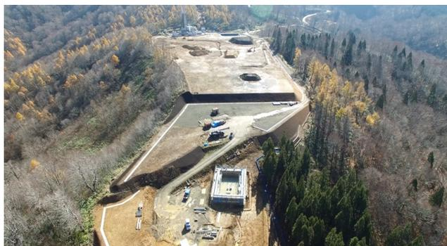
図-8 発電所およびWC坑井基地（手前）の敷地造成工事状況（2015年11月）
