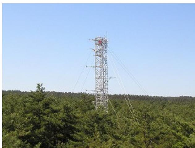
図6 CO<sub>2</sub>フラックス計測のための観測タワー(森林総合研究所HP)
