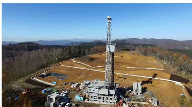
図-9 WA基地における生産井掘削工事（2015年11月）
