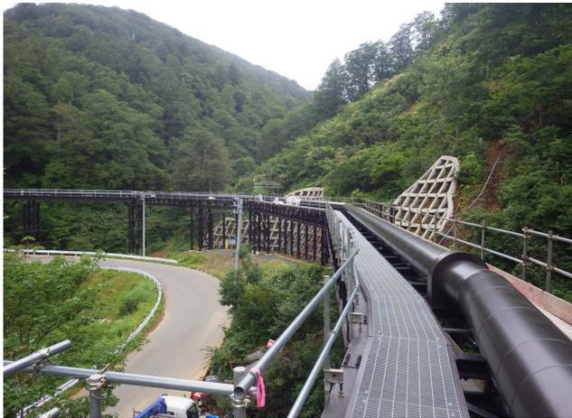
図-15 還元熱水輸送管設置（2018年8月）
