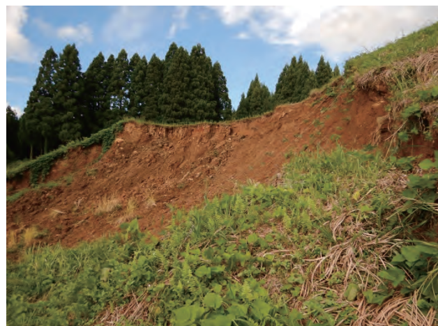
写真2 豪雨により崩れた斜面
