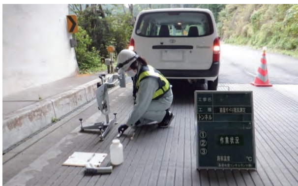
写真1 トンネル点検での路面滑り抵抗調査
