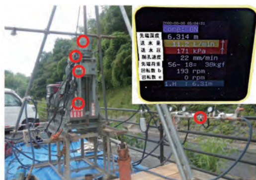
写真-2 センサー取付状況(右上は計測中のモニター画面。赤丸はセンサー位置。上から、回転、掘進速度、給圧(下降)、給圧(上昇)、送水量・送水圧)
