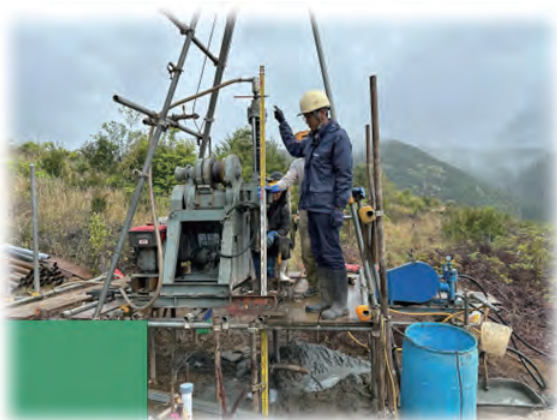
写真3 ボーリング現場での現場管理状況
