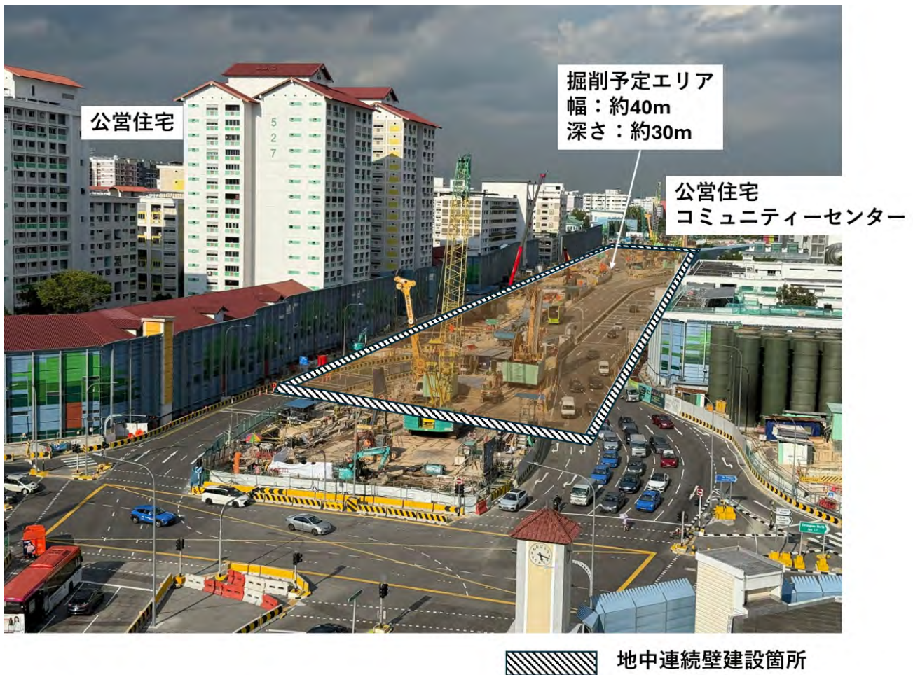
図-2 クロスアイランド線1工区の現場状況写真
