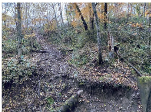
写真-2 何度も登り下りした道路のり面。 変状した構造物の補修設計のための 地質調査。
