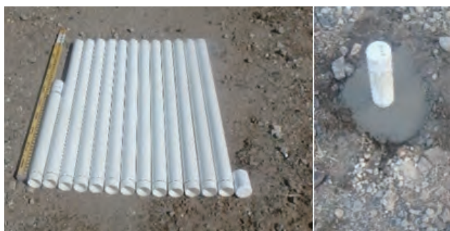
図2 井戸材挿入前・挿入後
