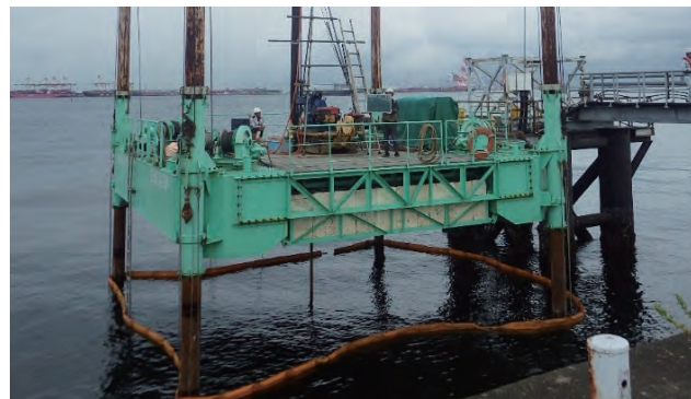
図1 海上ボーリング施工状況
