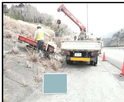
小型移動式クレーンによる揚重作業状況（例）
