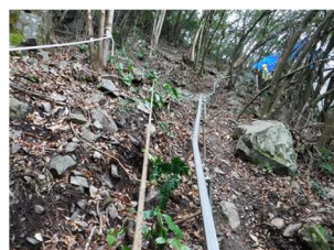
運搬用モノレール架設状況
