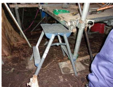
高さ 50cm 程度の段差への昇降設備 設置例
