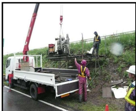
小型移動式クレーンによる揚重作業状況（例）
