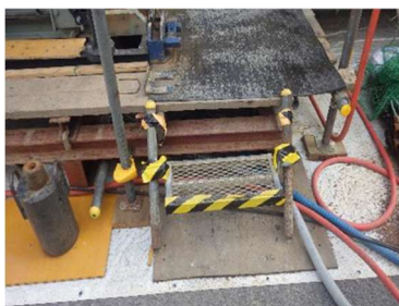
高さ 50cm 程度の段差への昇降設備 設置例
