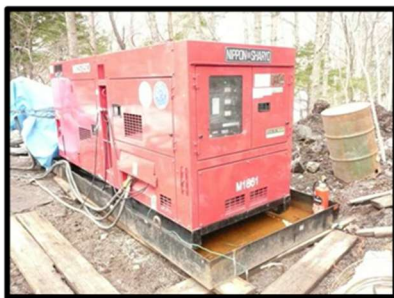
発電機下部への油漏れ防止 措置(オイルパン設置)
