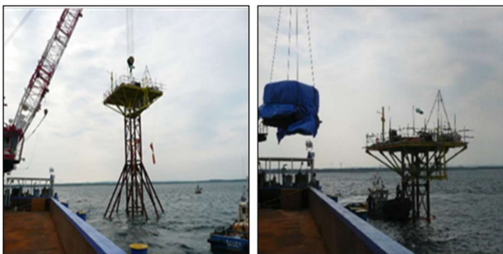
クレーン台船による鋼製やぐらの移設作業状況
