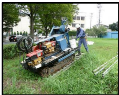
平坦地搬入状況
