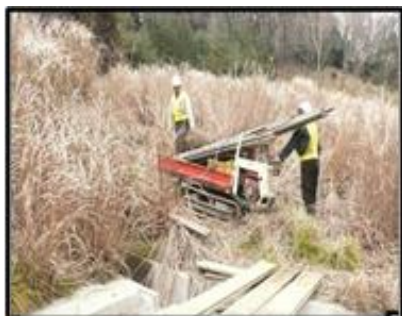
緩斜面搬入状況
