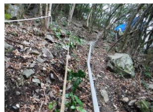
運搬用モノレール架設状況
