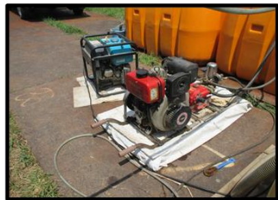
油漏れ防止措置
