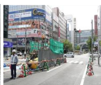
市街地 全足場
