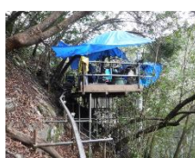
山間部 片足場
